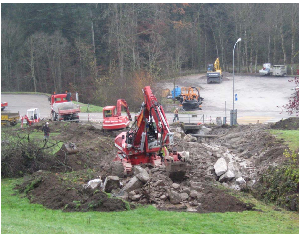
Sanierung Moosgräbli Unterlauf (Foto vom 18.11.2008)
