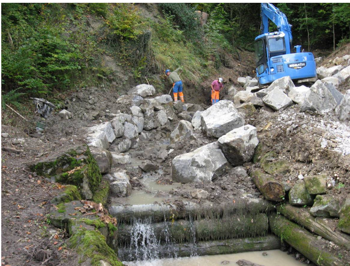
Blöcke versetzen, Raygräbli (Foto vom 07.10.2008)
