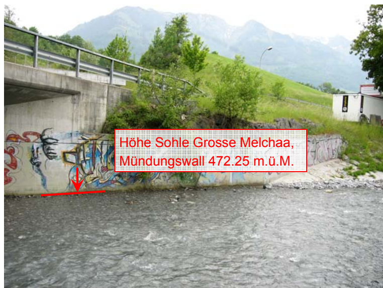
Abb. 3: Brücke Brünigstrasse, Widerlager Seite Sachseln im Sommer 2008 (Foto L1100703 vom 29.05.08)
