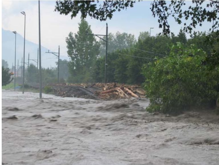
Abb. 6: Dambruch Zentralbahndamm nördlich der verkleusten zb-Brücke bei HW2005 (Foto flug_0900_006 vom 23.08.05, 07.53 Uhr)
