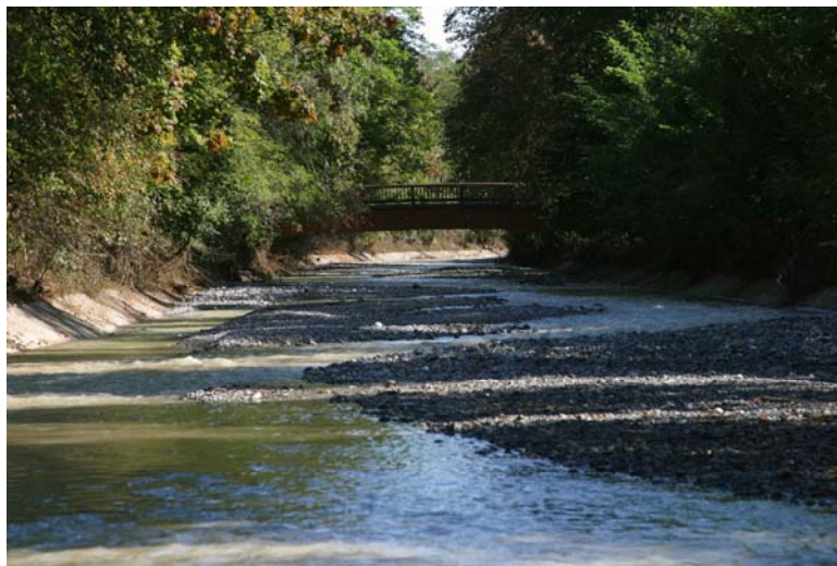
Abb. 13: Auflandung in der Melchaa zwischen Autobahnbrücke und Brücke Autobahnzubringer nach Hochwasser 2005, ca. 0.7 m über der normalen Sohlenlage, Kiesräumung im Nov. 2005 ca. 2'000 m 3 (Foto winter_melchaa_069 vom 13.09.05)
