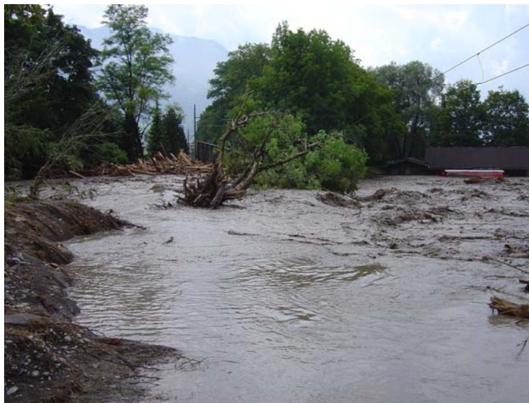
Abb. 5: Dammbbruch Melchaadam oberhalb zb-Brücke bei HW2005 (Foto britschgi_sarnen_026 vom 23.08.05, 13.35 Uhr)
