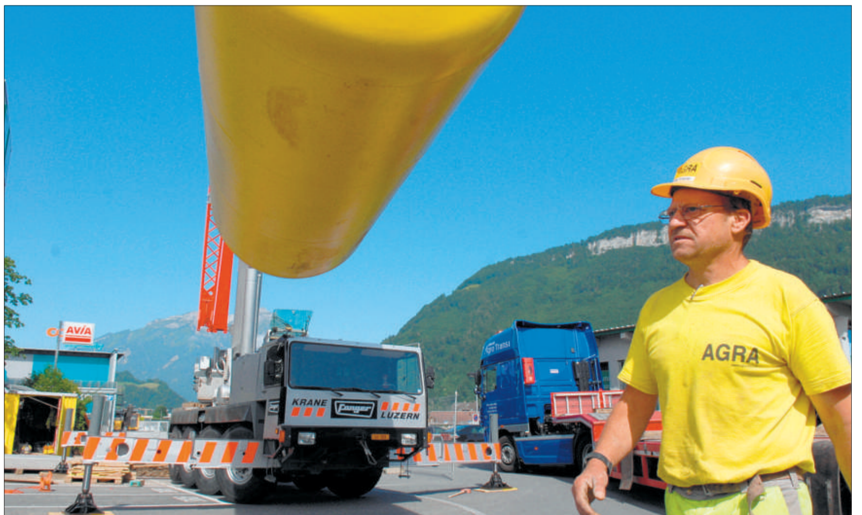
Polier Jost Mathis vom Ennetbürger Bauunternehmen Agra AG hilft mit, einen 32 000-Liter-Gastank bei der Tankstelle Guetli Shop zu installieren.
