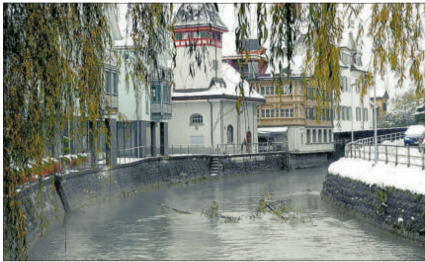
Vorerst keine veränderte Ausgangslage für den Hochwasserschutz Sarneraas. BILD RH
