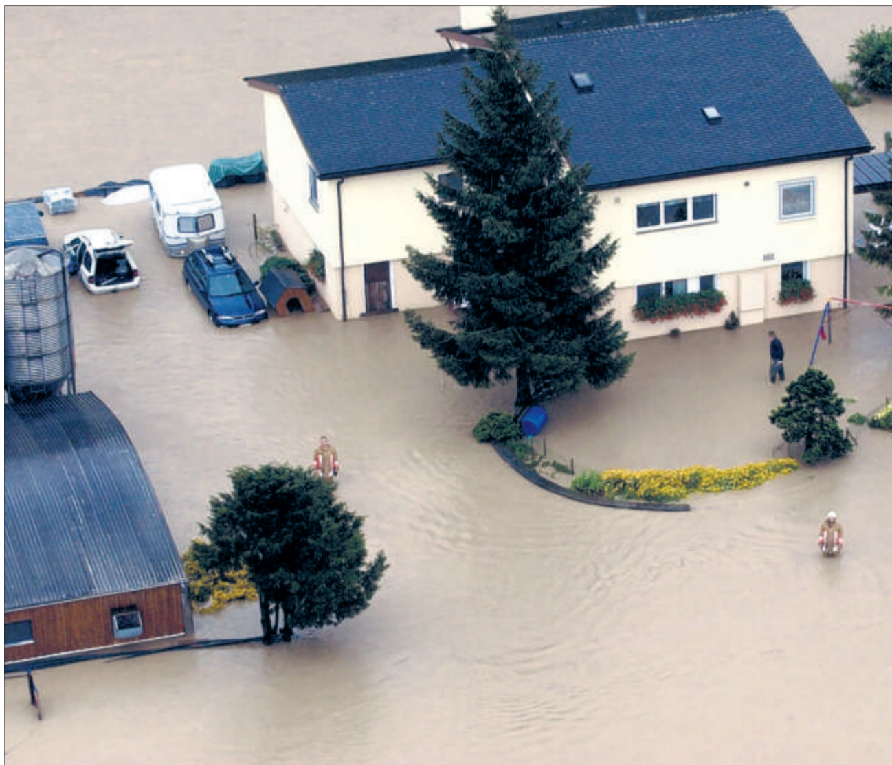
Die Folgen der Unwetter vom August 2005 waren gravierend, wie dieses Bild einer Liegenschaft zwischen Alpnach und Sarnen zeigt. Doch jetzt fehlt dem Bund das Geld für die Unterstützung von Schutzbauten.
