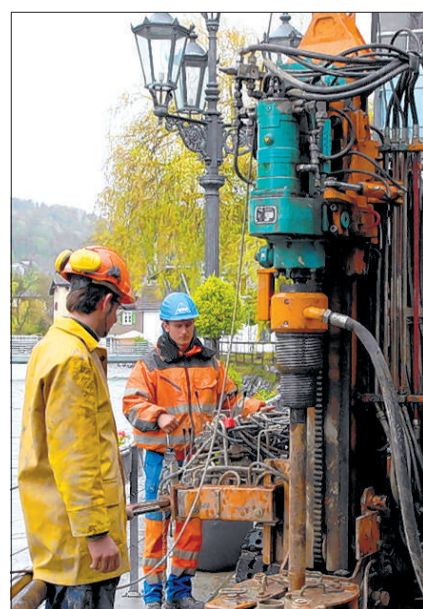
Zwei Arbeiter führen bei der Sarneraa Sondierbohrungen aus.
