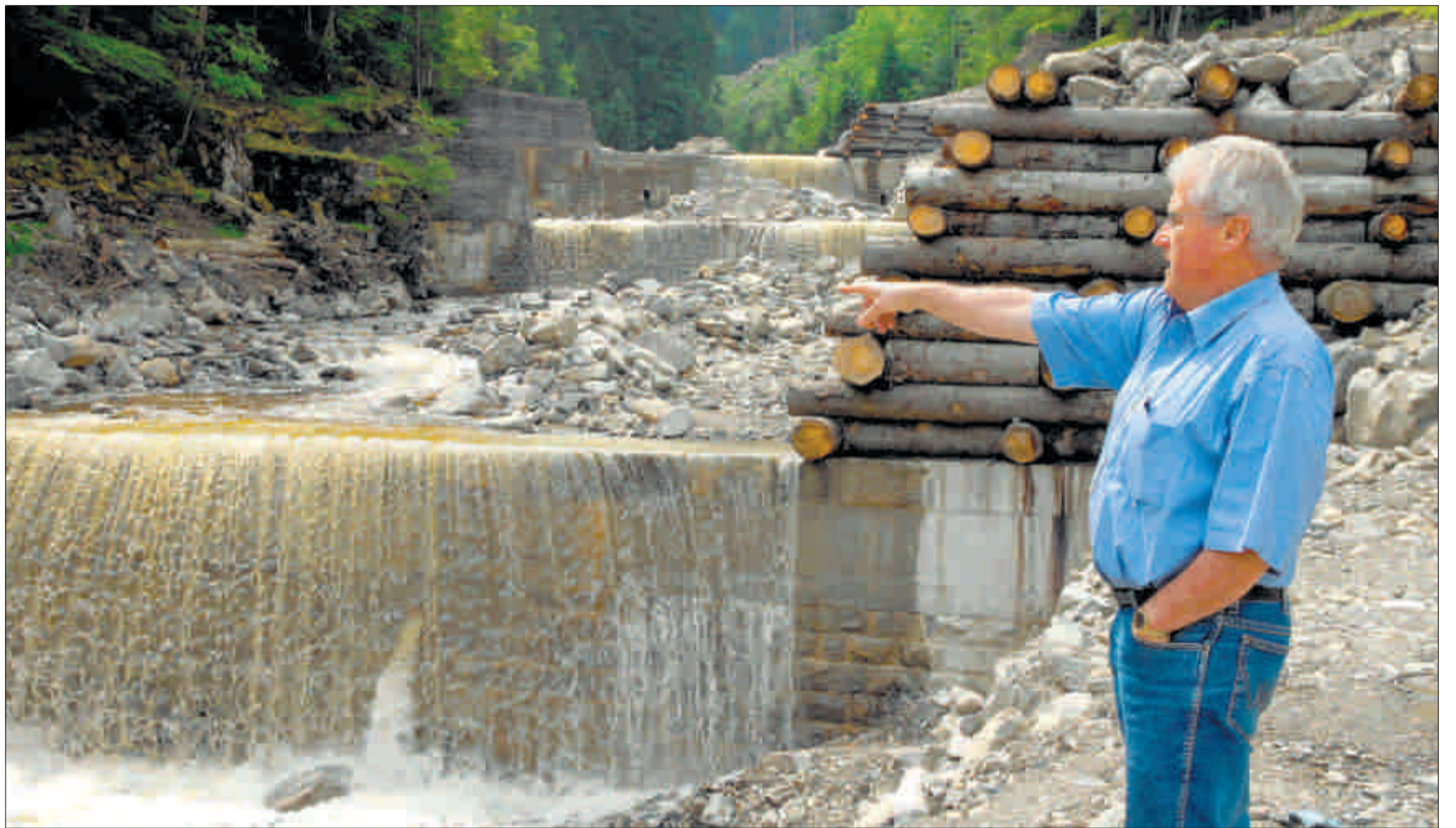
Wuhrgenossenschaftspräsident Peter Jöri berichtet über die Sanierungsarbeiten an den Geretschwandsperrren. Rechts die Holzkastenverbauungen.
