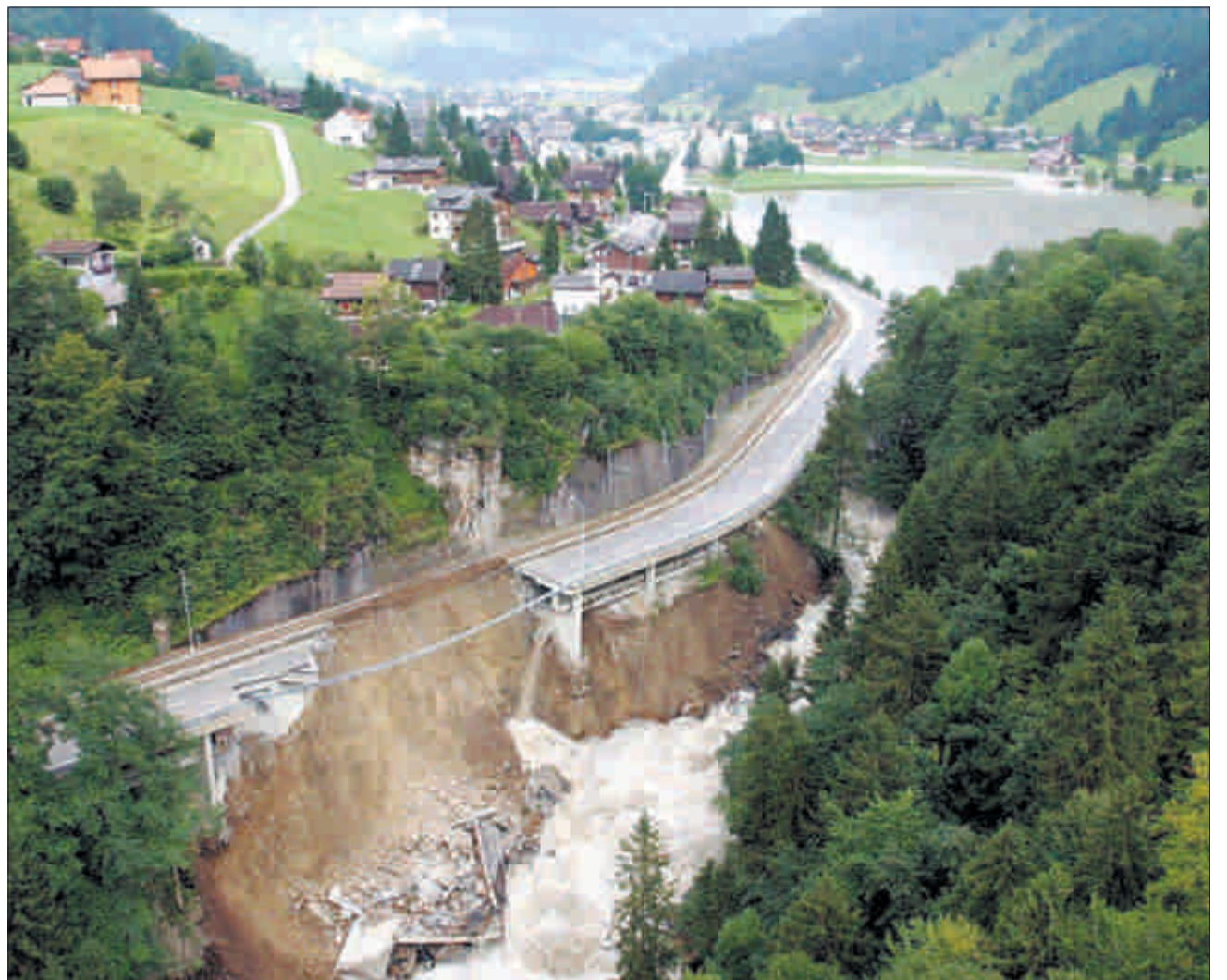
Die zerstörte Strasse und Bahnlinie am Dorfeingang zu Engelberg im August 2005.
