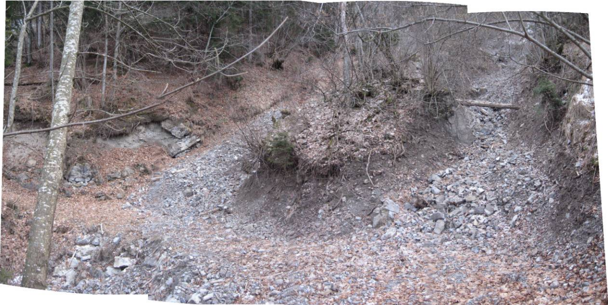
Abb. 3: Oberster Bewirtschaftungsweg Sommerweid Kote 820, nordöstliche Hauptrunse und südwestliche Seitenrunse (rechts im Bild), 20.02.2008
