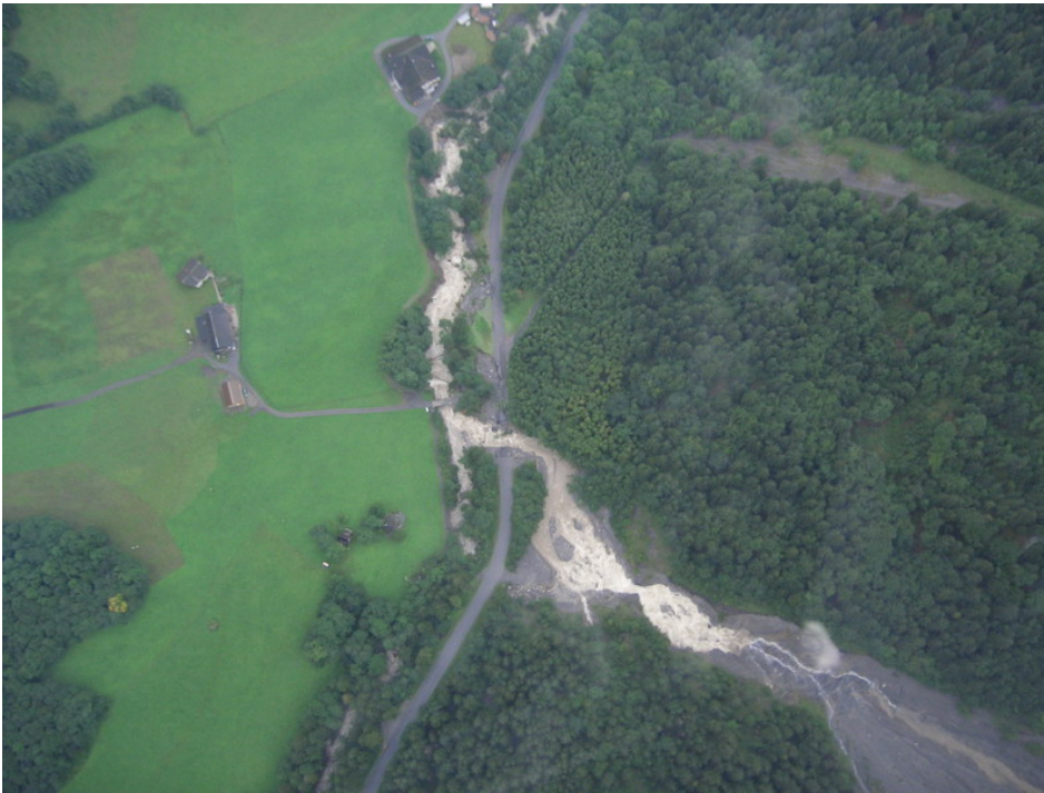
Abbildung 32: Die Wassermassen der Karstquellen in der Löcherflüe (unten rechts) führten zu starken Erosionen im Bärenbach.
